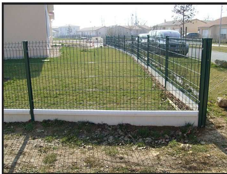
Clôture à poser en façade des voies de circulation et trottoirs.
